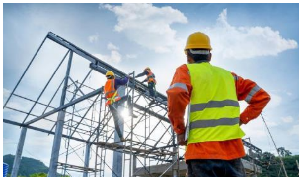
Travailler sur un toit
