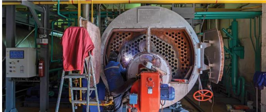
Interventions dans les équipements de chaleur
